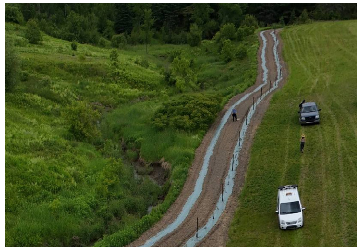
Image 2 (vue aérienne d'une parcelle aménagée montrant une zone d'érosion du talus)
