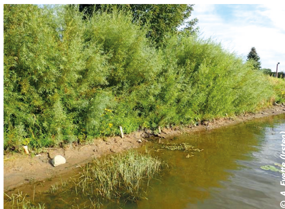
② Protection d'une berge initialement érodée par le battillage, stabilisée avec un matelas de branches. La photo a été prise trois ans après les travaux, dans la région de Lanaudière près de Montréal.
