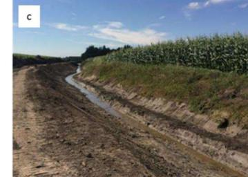
Figure 8. Différentes approches pour l'aménagement d'un cours d'eau à deux niveaux : a) excavation de plaines ; b) aménagement de banquettes ; c) excavation d'un sillon (MRC Brome-Missisquoi, © Simon Lajeunesse).
