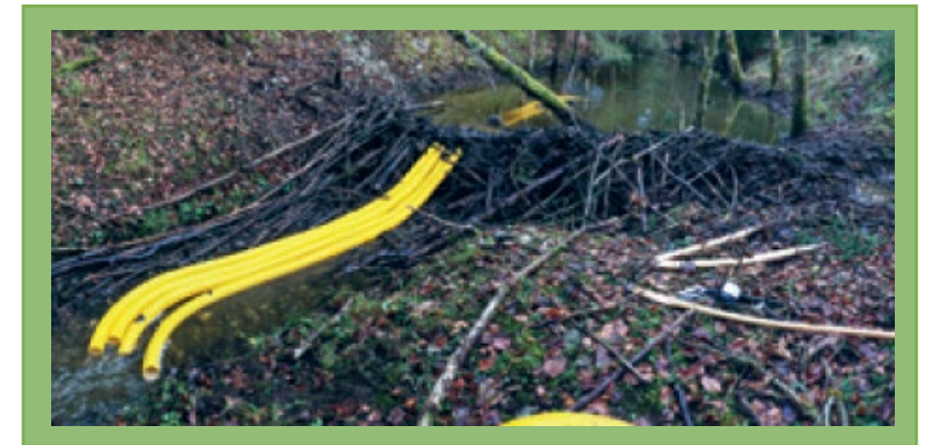
Installation de drains dans un barrage
