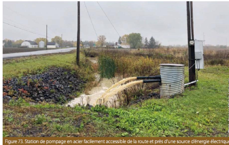
Figure 73. Station de pompage en acier facilement accessible de la route et près d'une source d'énergie électrique
