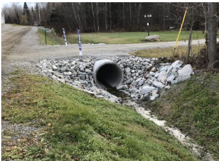
Remplacement d'un ponceau et entretien du cours d'eau empruntant le fossé de voie publique. Source Ville de Sherbrooke
