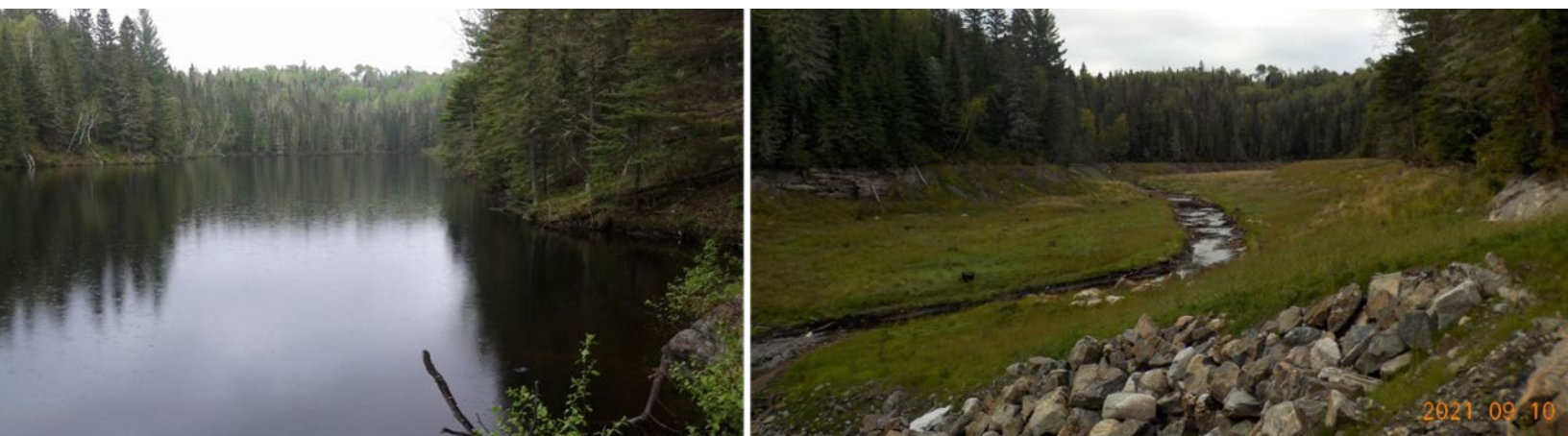
Figure 1 : avant/après le démantèlement d'un barrage. Source : Direction générale des barrages (MELCC).
