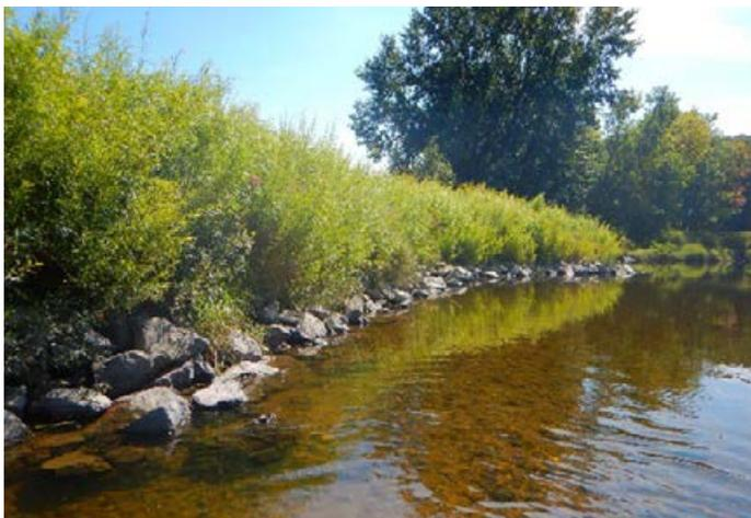
*Photo 4: Stabilisation d'un méandre de la rivière Nicolet (Centre-du-Québec) le long d'un champ de cultures. L'ouvrage a été construit pour contrôler l'érosion et stopper la perte de terrain. Un cordon de roches a été placé en pied de berge et des couches de branches à rejet sur le reste de la berge.*
