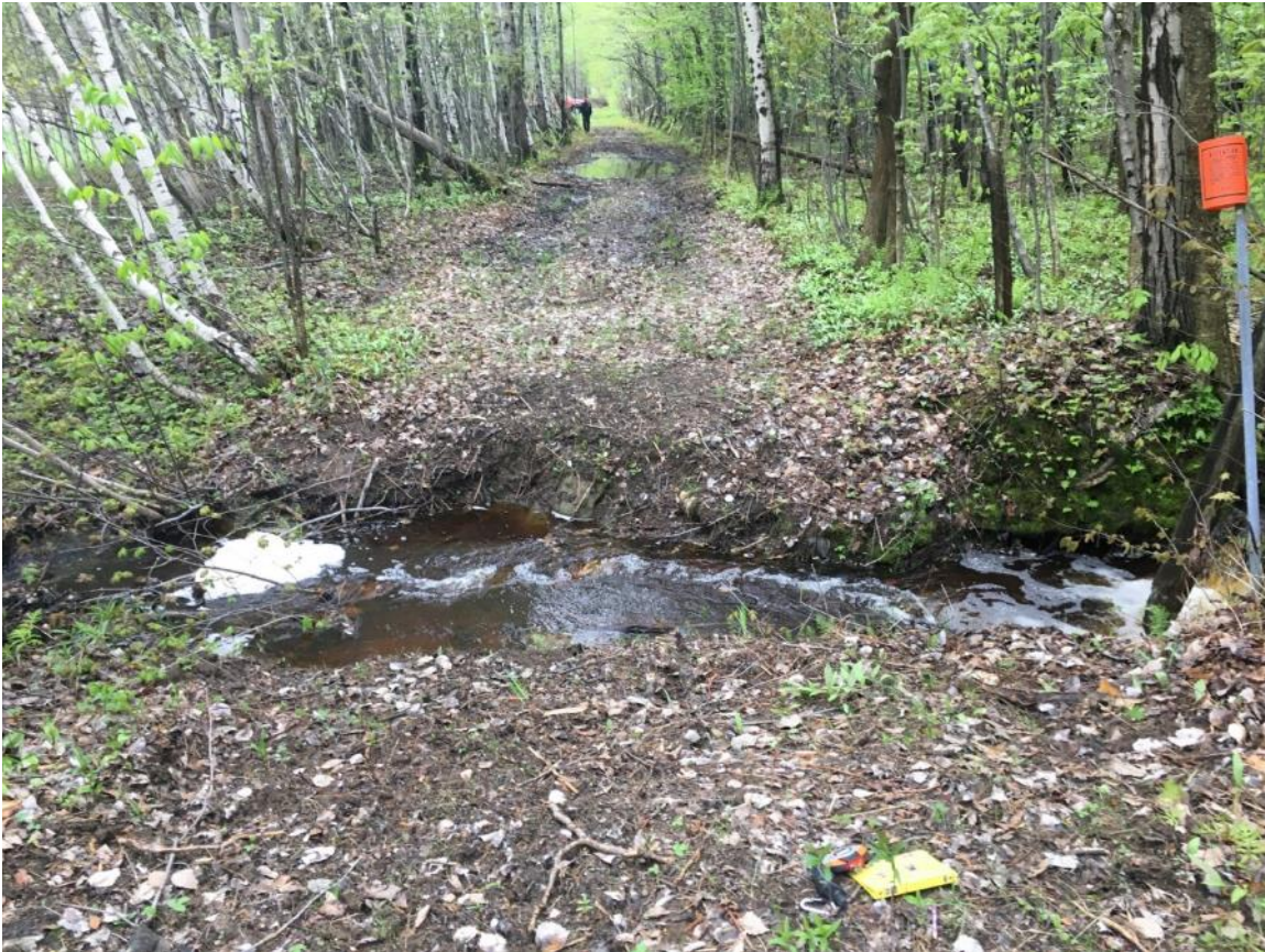
Photo du site : Pont faible tonnage sur culée de béton avant travaux
