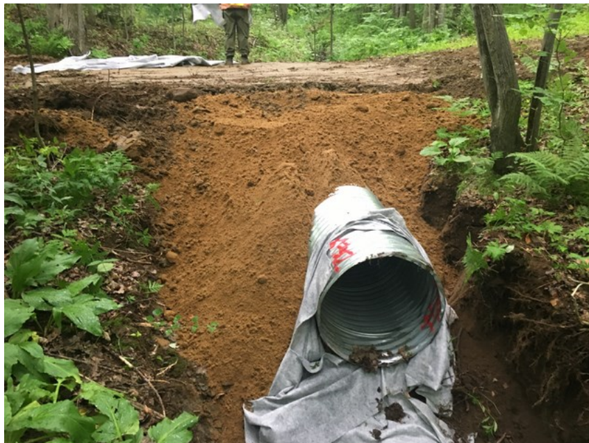
Épaisseur minimum de remblai sur ponceau (MFFP RADF)
