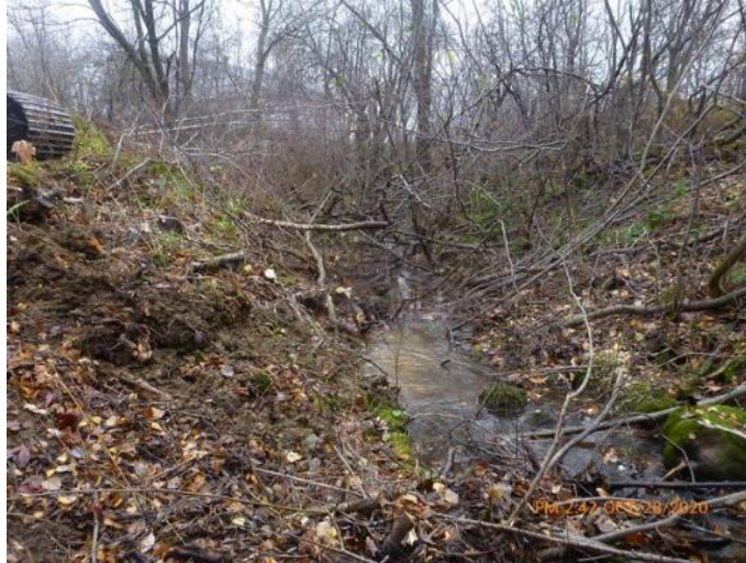
Photo du site : Traverse à gué avant travaux
