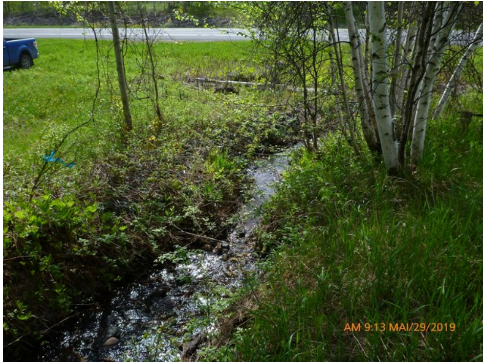
Photo du site : Ponceau béton-bois avant travaux
