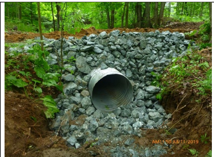
Stabilisation talus + clé d'ancrage
