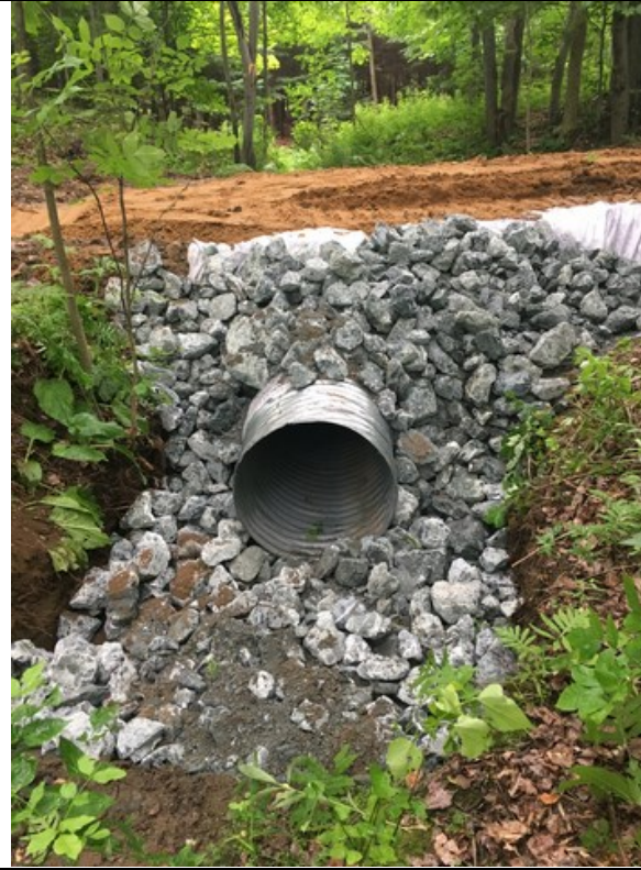
Clé d'ancrage recouverte de pierres
