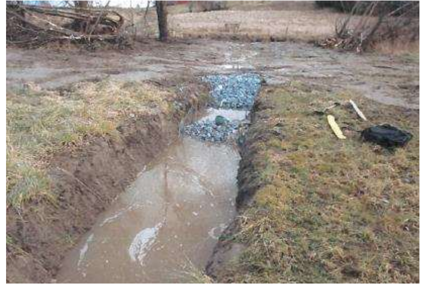
7 Bassin de stockage
