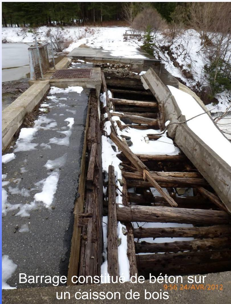
Barrage constitué de béton sur
