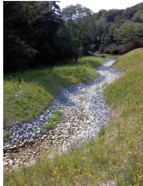
Première décharge (près de St-Jude), Montérégie Est. Enroché en 2012 sur 550 m (à 4000$/m, soit 2,2 millions$)
