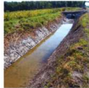
Photo 2 Vue aval du bassin #2
