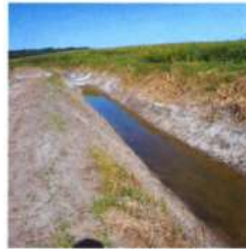
Photo 1 Vue amont du bassin #2
