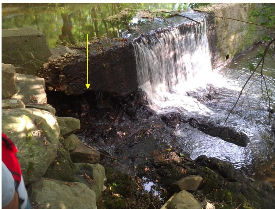
Figure 3. Trou représenté par la flèche jaune, cette faille dans la structure est portée à la connaissance de la MRC.
